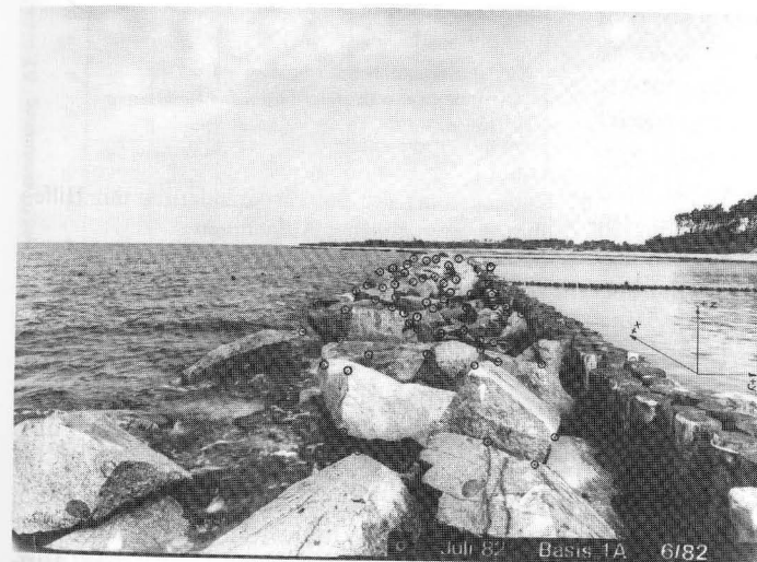
Abb. 11. Meßbild von der Basis 1 A mit eingetragenen Meßpunkten zur photogrammetrischen Auswertung
