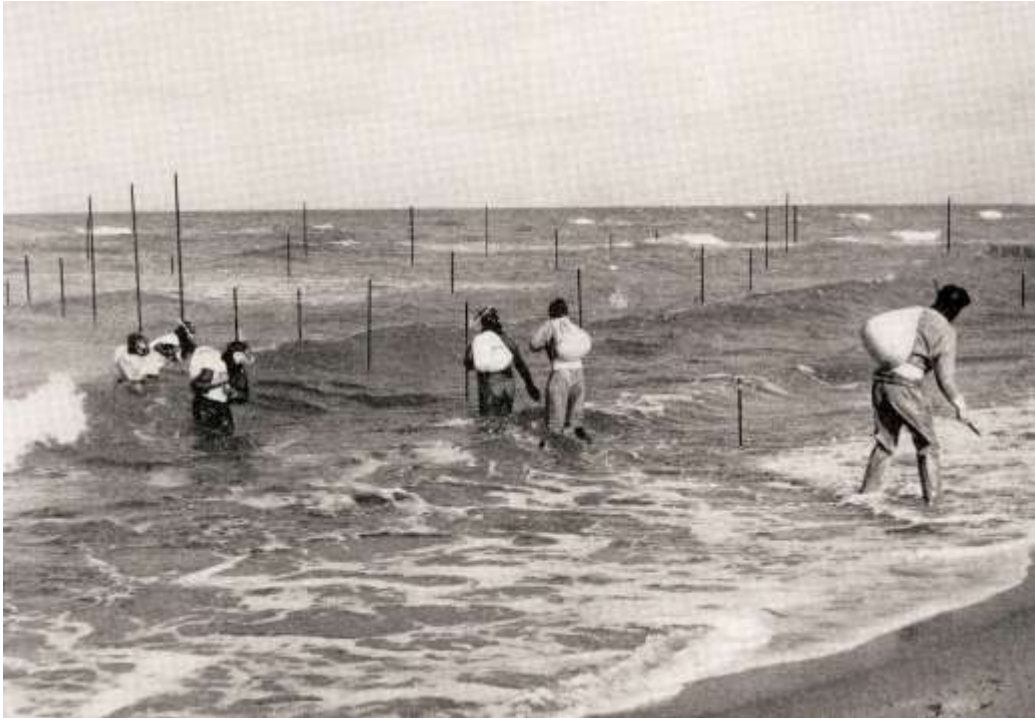
Abb. 31: Taucher beim Ausbringen des Farbsandes in einem mit Eisenrohren abgesteckten Bühnenfeld vor dem Fischland im Oktober 1964 (aus KOLP, 1966b).
