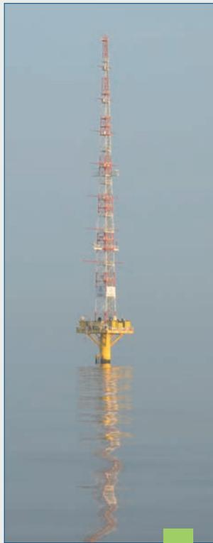
*Auf der Forschungsplattform FINO<sup>2</sup> ist das IOW für die Entwicklung und Installation der hydrographischen Messsysteme verantwortlich. / At the research platform FINO<sup>2</sup> IOW is responsible for the development and installation of the hydrographic measurement systems. (Foto / Source: IOW)*
